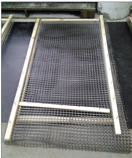
Fotografia 3. Jedna z płyt przed zabetonowaniem – widoczne listwy krawędziowe mocujące siatki bazaltowe
